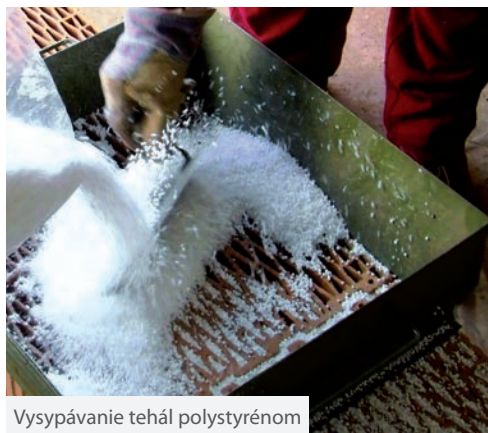
Polystyrén v ostení s krajovými tehľami
