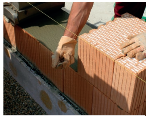
HELUZ celoplošné lepidlo na tehľách FAMILY 2in1
