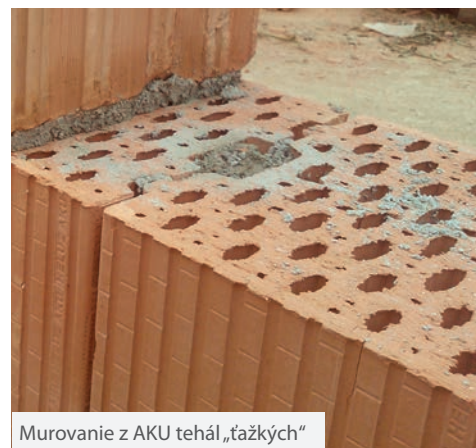
Murovanie z AKU tehál zalievaných
