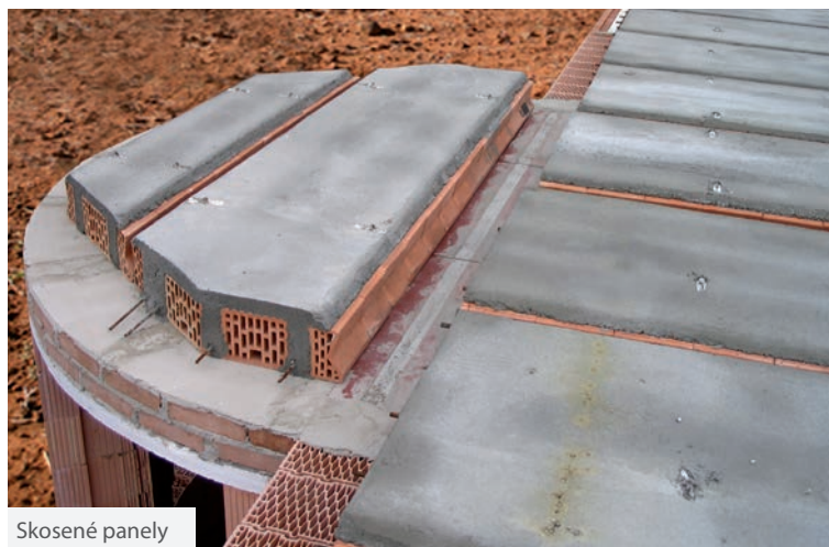
Rýchlosť montáže kladenia panelov – cca 140 m 2 za 2 hodiny
